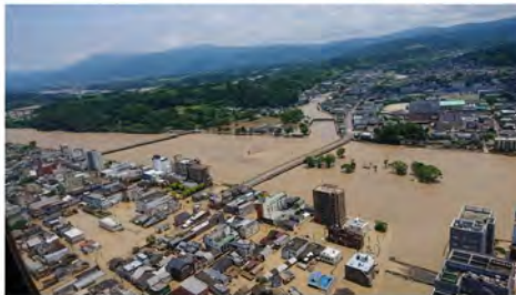
令和2年7月4日熊本県南部豪雨災害
