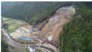
大分県中津市耶馬溪町の山腹崩壊 降雨後数日たったの崩壊
