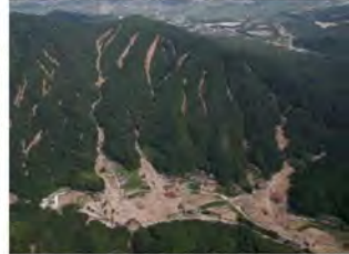
広島県呉市の山腹崩壊状況
